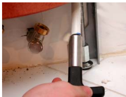
4. Rohr kalibrieren und entgraten.
