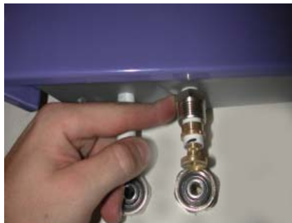
5. Klemmverschraubung, Klemmring und Tülle aufstecken.
