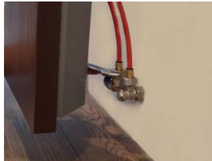
2. Rohr mit Ventil verschrauben.
