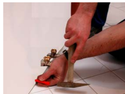
8. Geeignete Dübel einsetzen. Beigepackt: Dübel für Mauerwerk.
