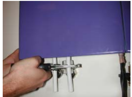
3. Spacey aufhängen, einrichten und Rohrleitungen ablängen.
