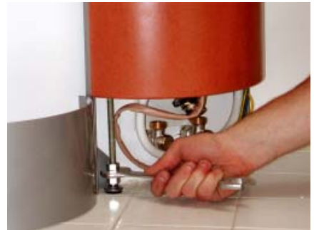
3. Höhe mit Stellschraube justieren.
