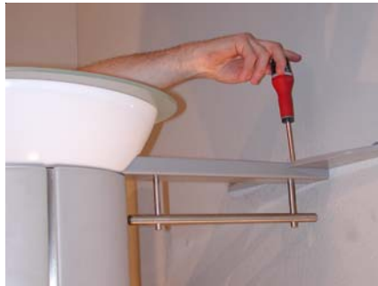
2. Garderobenstange an oberen Wandhalter anschrauben.
