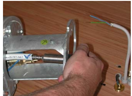
3. Heizungsrohr DN 14 mm kalibrieren und entgraten.
