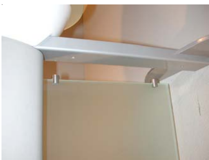
7. Zwei Glashalter an oberer Kante aufsetzen und einschwenken.
