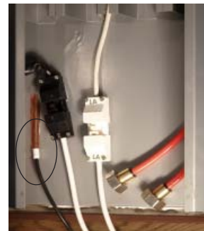
3. Fühler in Tauchhülse einführen.
