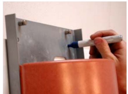
6. Anzeichnen der Bohrlöcher oben.
