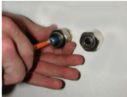
2. Ausgleichstüllen an Heizungsanschlüssen montieren.
