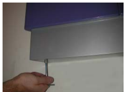
9. Sockelblende mit Imbusschlüssel montieren
