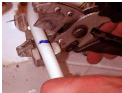
3. Rohr ablängen
