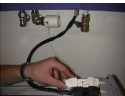
7. Antrieb an Ventil anbringen. Stecker verbinden.
