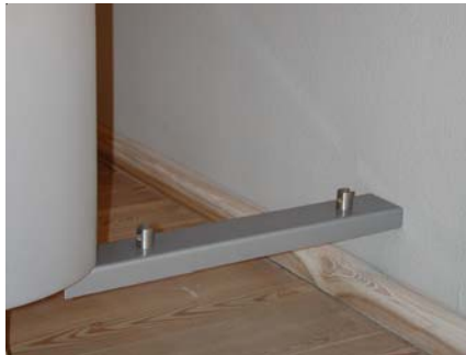
5. Zwei Glashalter am unteren Wandhalter verschrauben.
