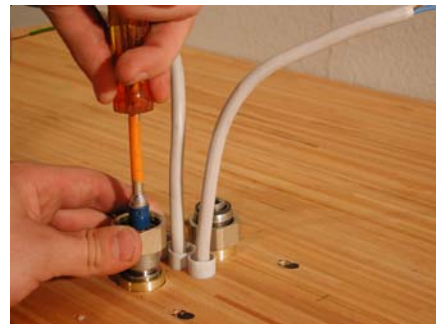
6. Heizungsanschl. bis Bodenoberkante verlängern; dann Anschlußnippel einschrauben.
