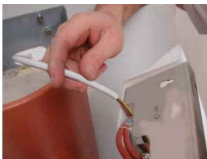
3. Kabel in Lampe einführen.
