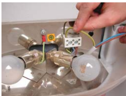
5. Herstellen des Elektroanschlusses.
