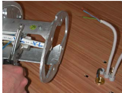
2. Heizungsrohr ablängen, s. Anschluß Bild 5.
