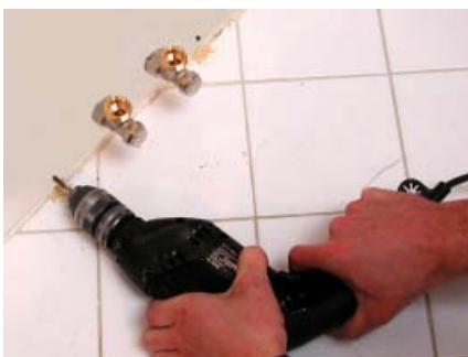
7. Befestigungslöcher bohren.
