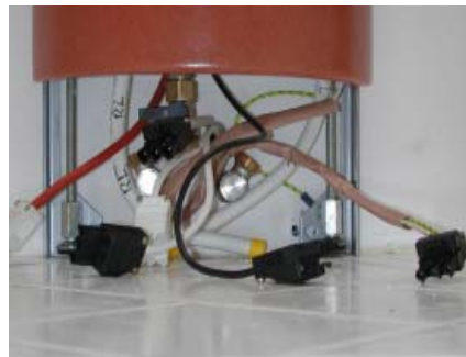
3. Werkseitig montierte Stecker an Heiz- und Fühlerleitung. Stecker für Licht beige packt.
