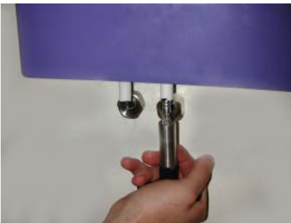
4. Anschlussrohr mit geeignetem Werkzeug kalibrieren.
