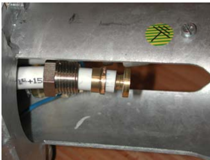
4. Klemmverschraubung, Klemmring und Tülle aufschieben.
