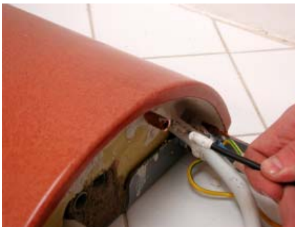
2. Einbau Fühler für Temperaturregler in Tauchhülse.
