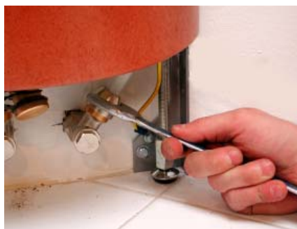
6. Rohr mit Ventil verschrauben.
