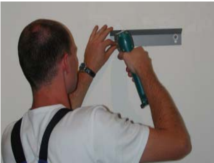
1. Befestigungswinkel montieren.
