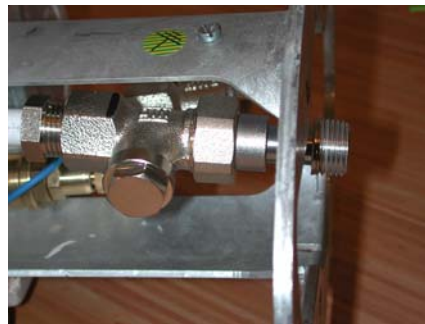
5. Rohr mit Klemmset an Absperrventil schrauben.
