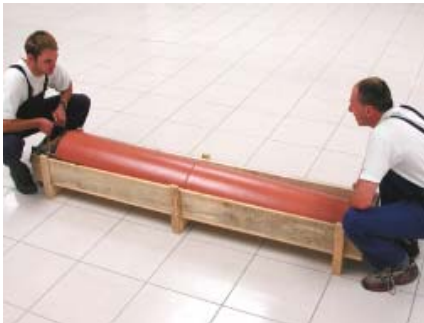
1. Objekt aus Transportkiste auspacken. Transportschrauben lösen.
