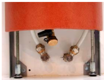
7. Fertig montierter Wasseranschluss.
