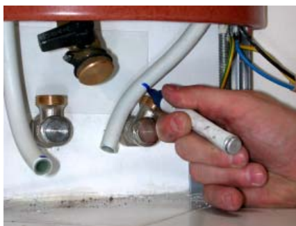
2. Rohrlänge anzeichnen.
